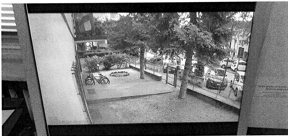
Telecamera 3 – Telecamera esterna cancelletto pedonale SUD
