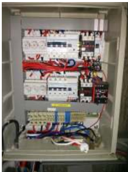
Fig. 10 Quadro elettrico generale I.P. a Mezzolombardo San Pietro 7 (QM05)
