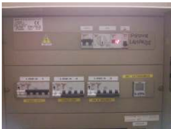
Fig. 19 Quadro elettrico generale I.P. a Mezzolombardo Tupini 19 (QM13)
