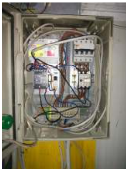
Fig. 12 Particolare quadro elettrico generale I.P. a Mezzolombardo Erbe 9 (QM07)
