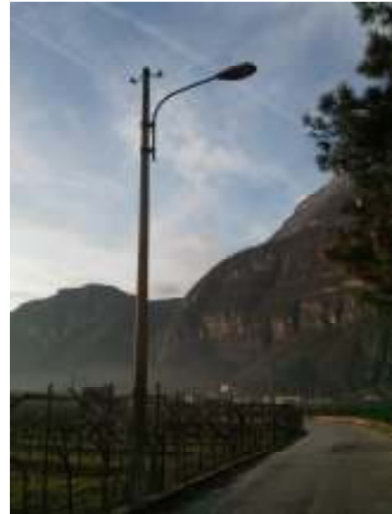
Fig. 34 Armatura stradale 125W HQL
