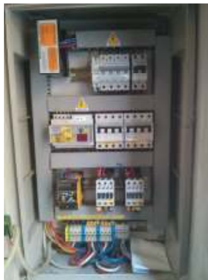
Fig. 14 Particolare quadro elettrico generale I.P. a Mezzolombardo Borghetto 11 (QM09)
