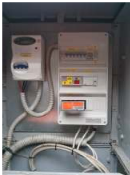
Fig. 32 Particolare quadro elettrico generale I.P. a Mezzolombardo Piani (GM25)
