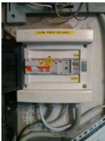
Fig. 8 Quadro elettrico generale I.P. a Mezzolombardo Noce 4 (QM03)
