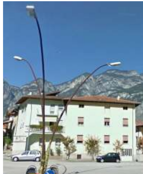
Fig. 36 Armatura stradale 250W SAP
