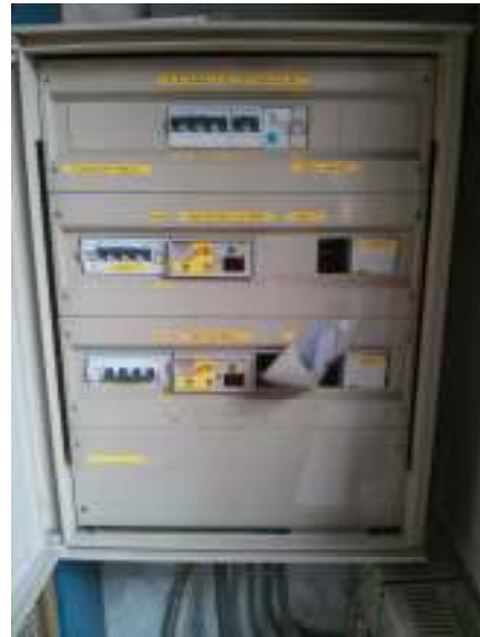
Fig. 22 Quadro elettrico generale I.P. a Mezzolombardo Filzi 22 (QM15)
